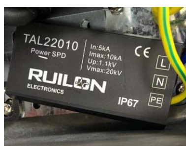
II.A.10 - Dispositivo de Proteção Contra Surtos de Tensão (DPS)
